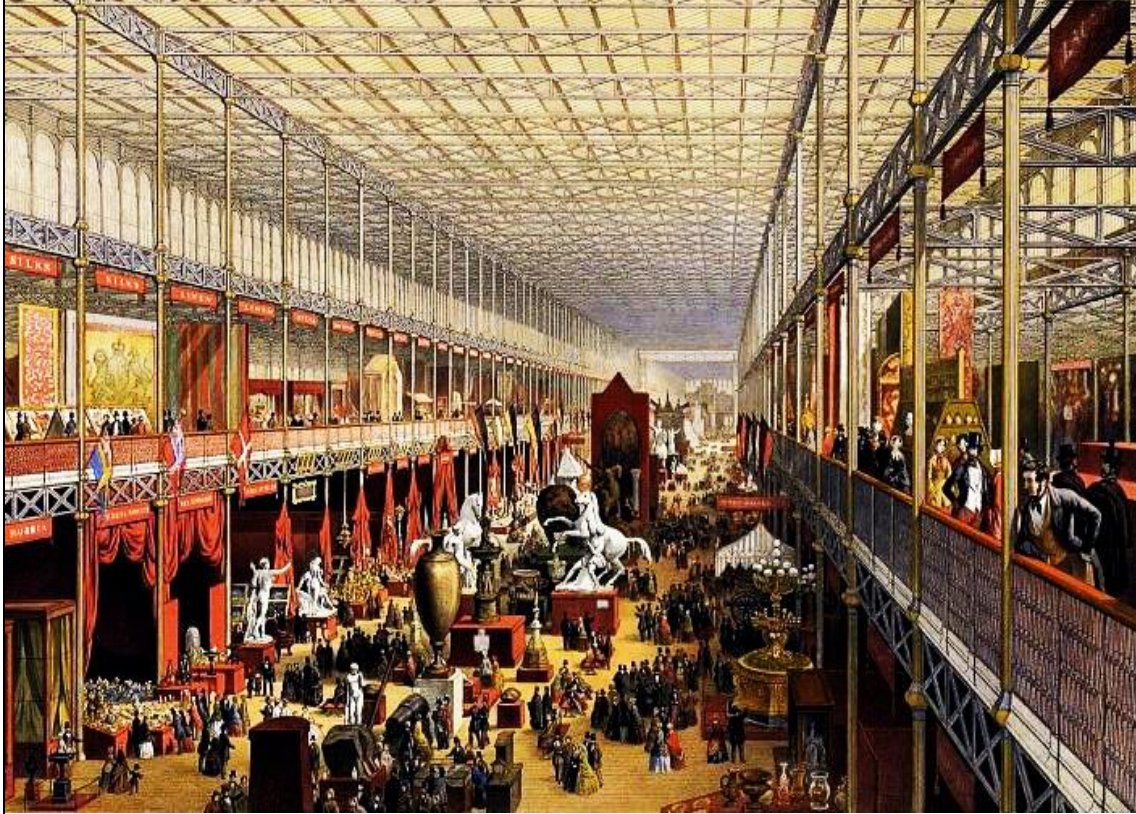
شكل (2-21) منظور داخلي لمبنى القصر البلوري (Crystal Palace) في لندن يظهر استخدام الوحدات المتكررة من الزجاج والحديد.
