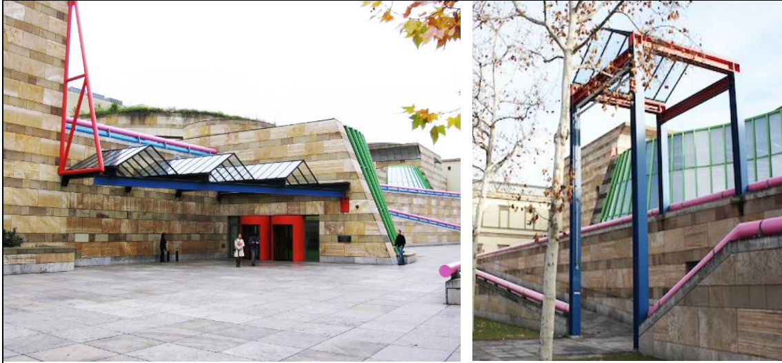
شكل (4-12) مناظير خارجية تبين منطقة المداخل لمعرض شتوتغارت الجديد (Neue Staatsgaleri) الزجاجية والتي توحى بأسلوبها إلى توجه الهائتك (Hi-tech) (المصدر: www.flickr.com )
