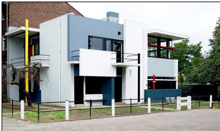
شكل (4-3) منزل ريتفالد- شرودر ( Rietveld Schröder House) غريت ريتفالد (Gerrit Rietveld)، إسبانيا (1924) (المصدر : www.flickr.com)
